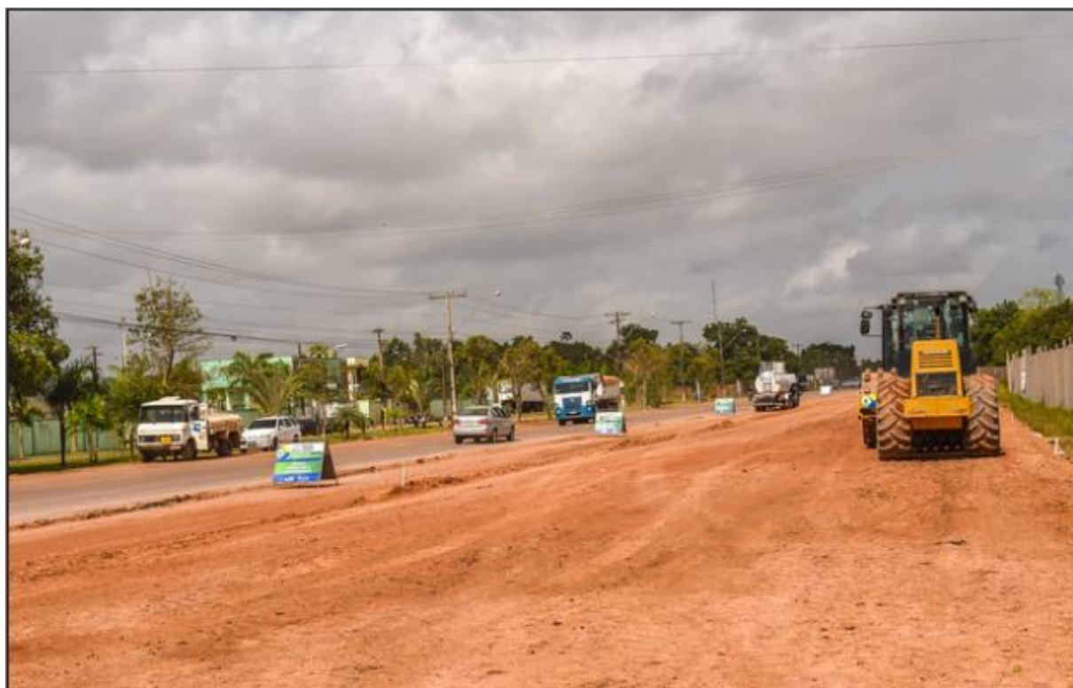
Foto 11 - Obras na Rodovia Duca Serra, 2021. Fonte: GEA
