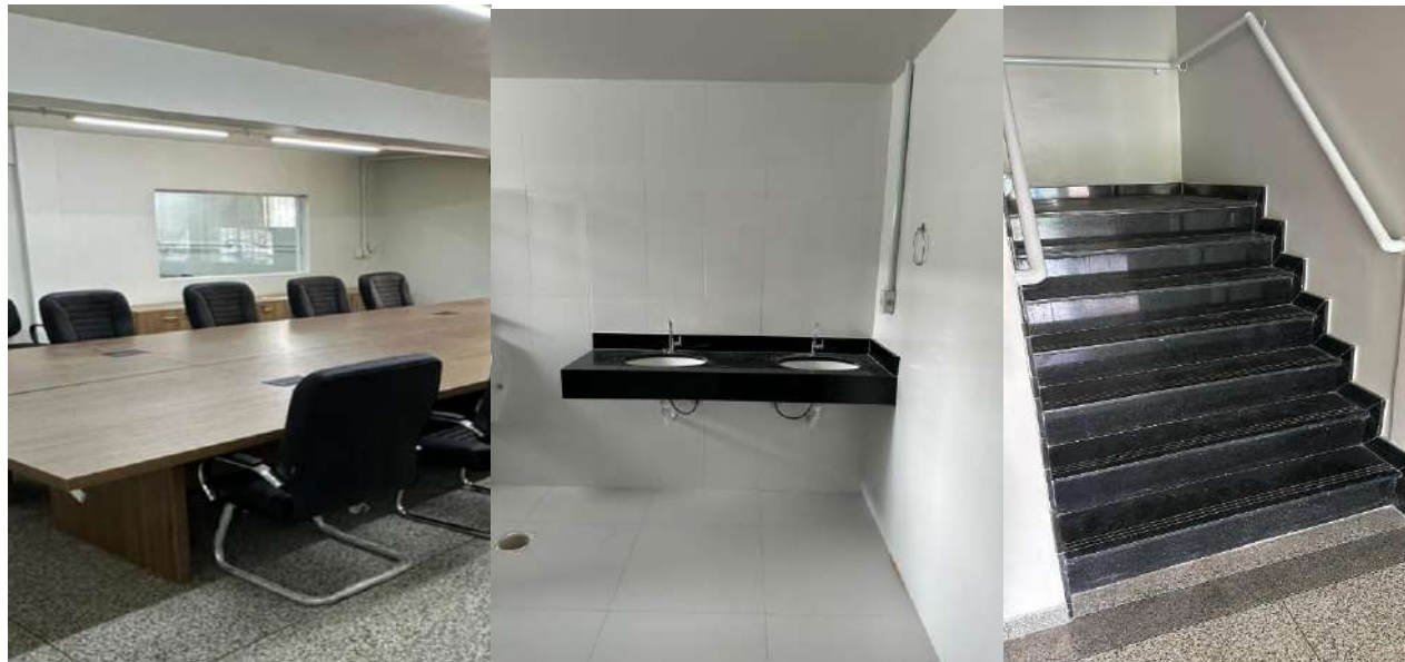
Figura 4 - Prédio da SEPLAN reformado.
