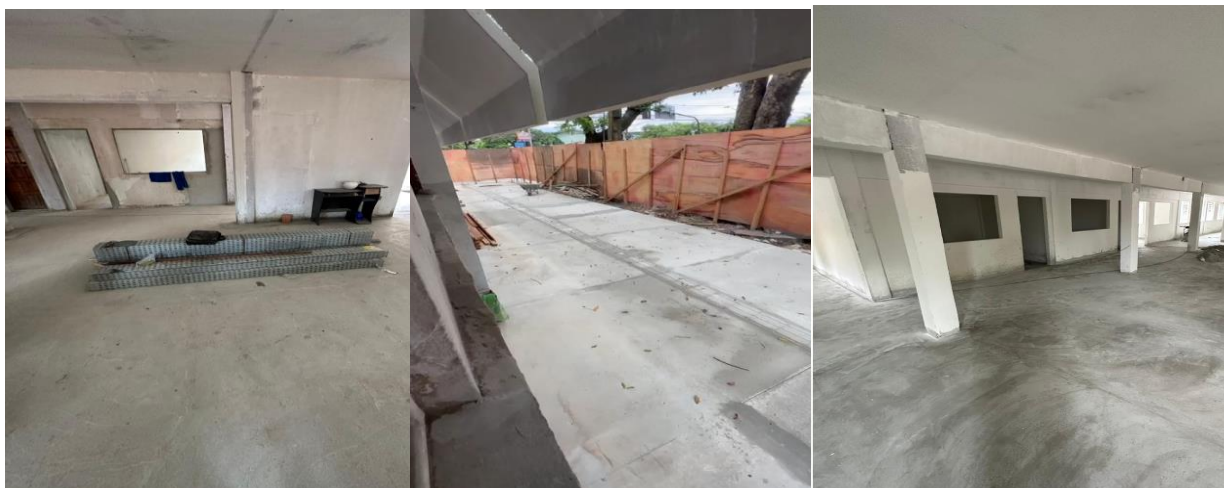
Figura 6 - Prédio da SEPLAN em reforma.
