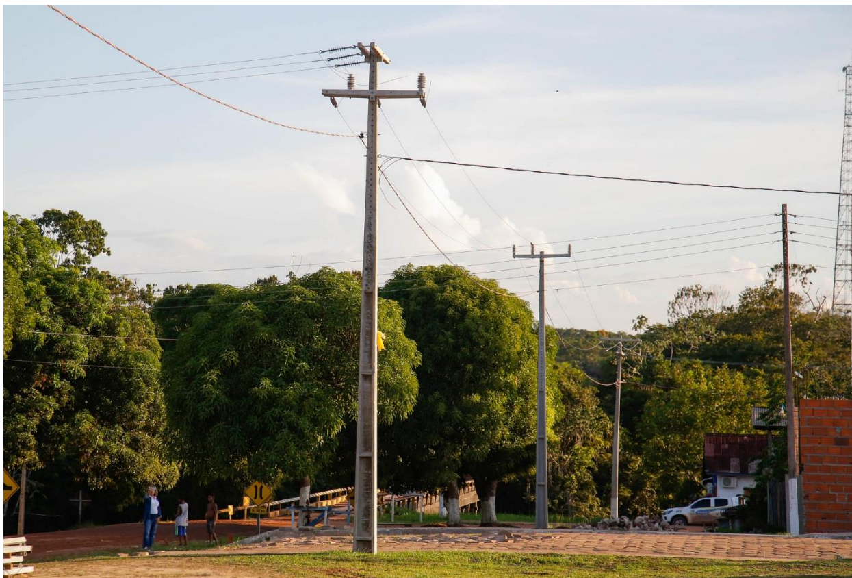
POSTES DE ENERGIA ELÉTRICA EM CONCRETO - MACACOARI -2022.
