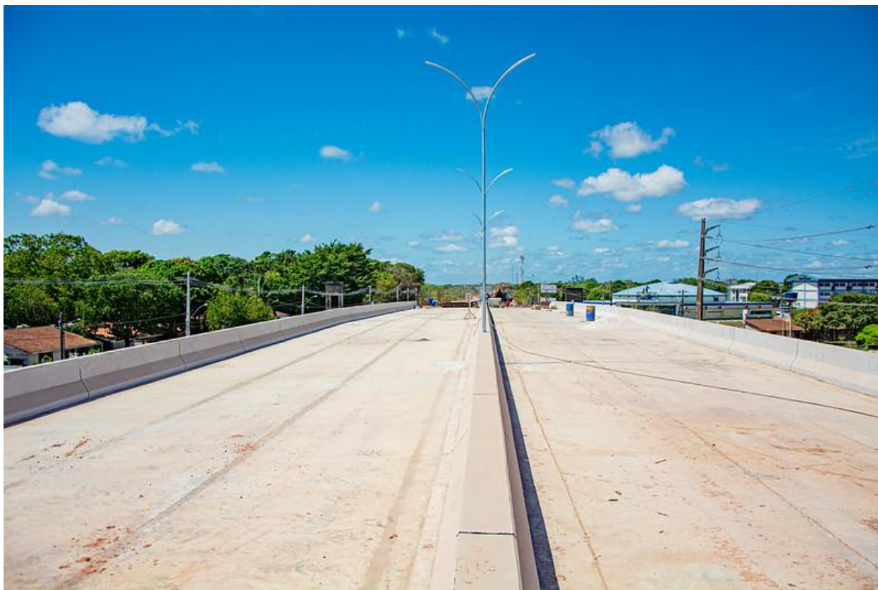
ELEVADO DA INTEGRAÇÃO - RODOVIA DUCA SERRA – 2022.
