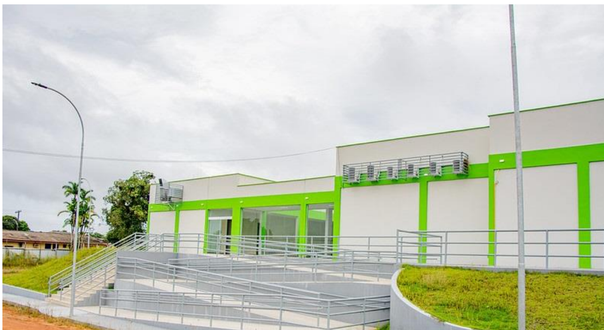
HOSPITAL REGIONAL DE PORTO GRANDE – 1ª ETAPA CONCLUÍDA – 2022
