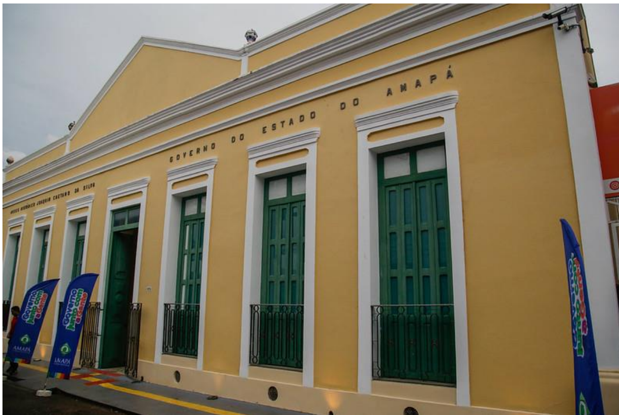
PRÉDIO DO MUSEU JOAQUIM CAETANO DA SILVA - REFORMADO – 2022.
