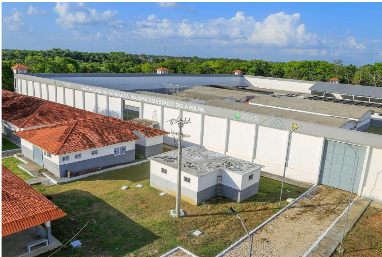
PENITENCIÁRIA DE SEGURANÇA MÁXIMA - ZONA OESTE DE MACAPÁ - CONSTRUÍDA EM 2022.
