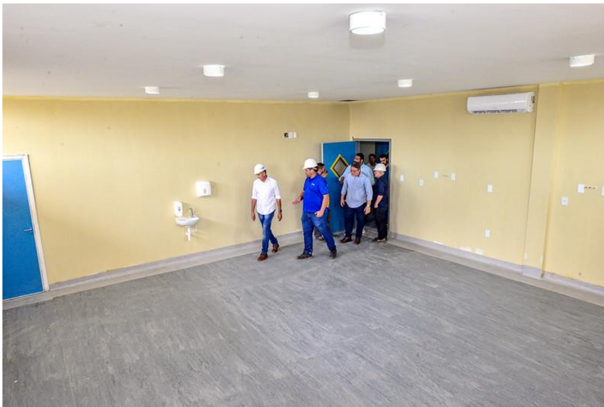
HOSPITAL DE SANTANA - 80% DAS OBRAS CONCLUÍDAS – 2022.
