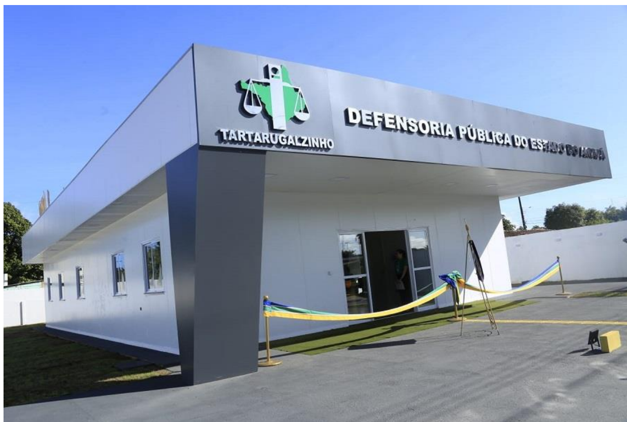
SEDE DA DEFENSORIA PÚBLICA DO ESTADO DO AMAPÁ - REFORMADA EM 2022.
