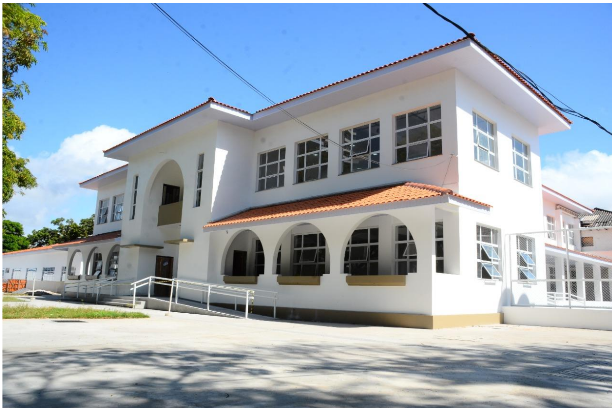
ESCOLA BARÃO DO RIO BRANCO TOTALMENTE REFORMADA - 2021.
