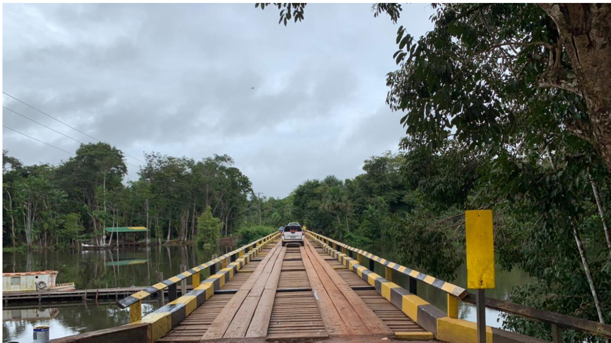
PONTES EM MADEIRA DE LEI REFORMADAS – 2021
