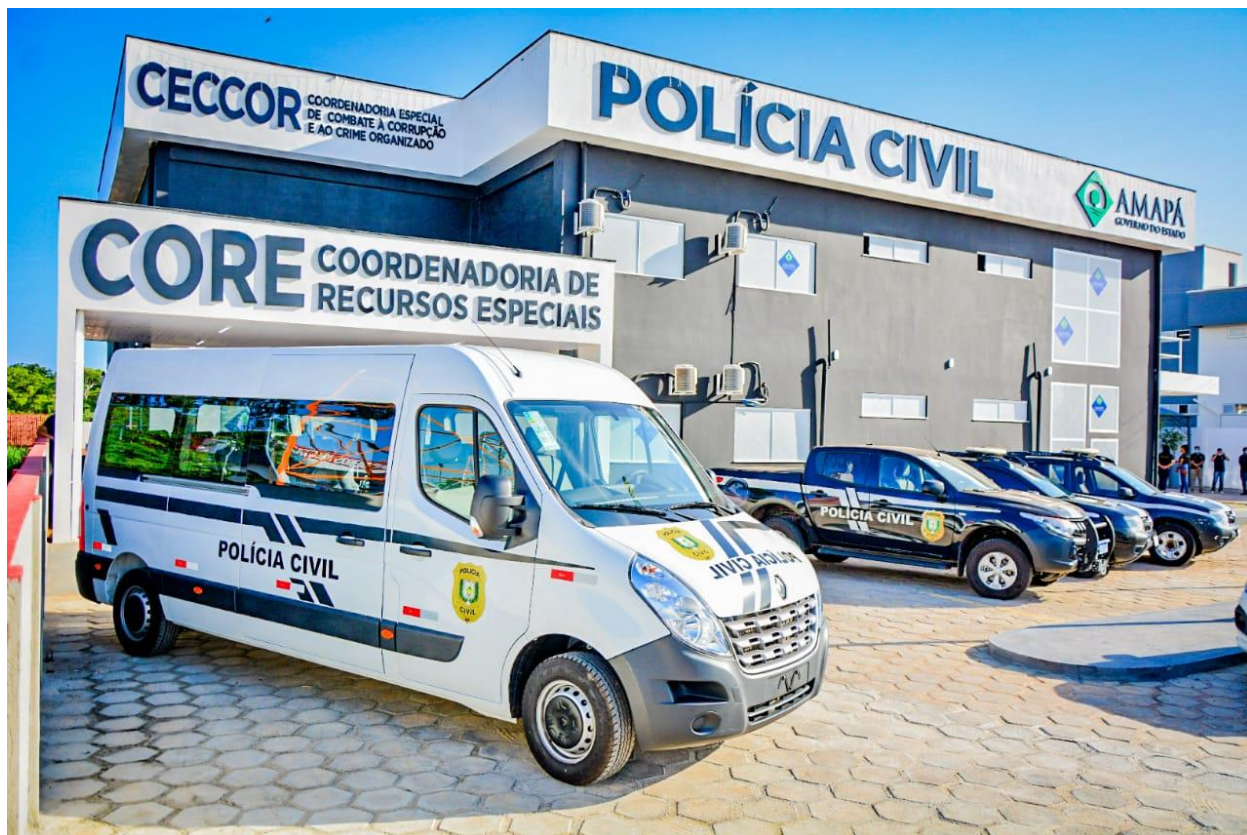
PRÉDIO DA POLÍCIA CIVIL – CIOSP DA ZONA OESTE DE MACAPÁ – 2021
